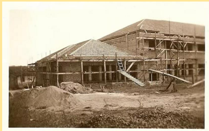
Construção do prédio 1950-1951
